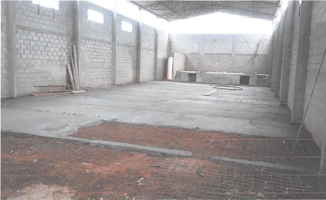
FOTO 07: Paredes com blocos de concretos, canaletas e piso com malha Q91:
