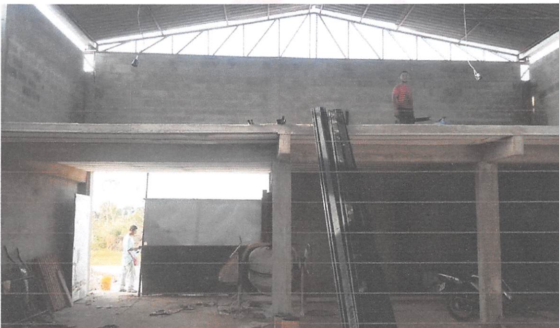
FOTO 04: Execução de sapatas, vigas baldrames, pilares, vigas aéreas e lage, sob minha responsabilidade:
