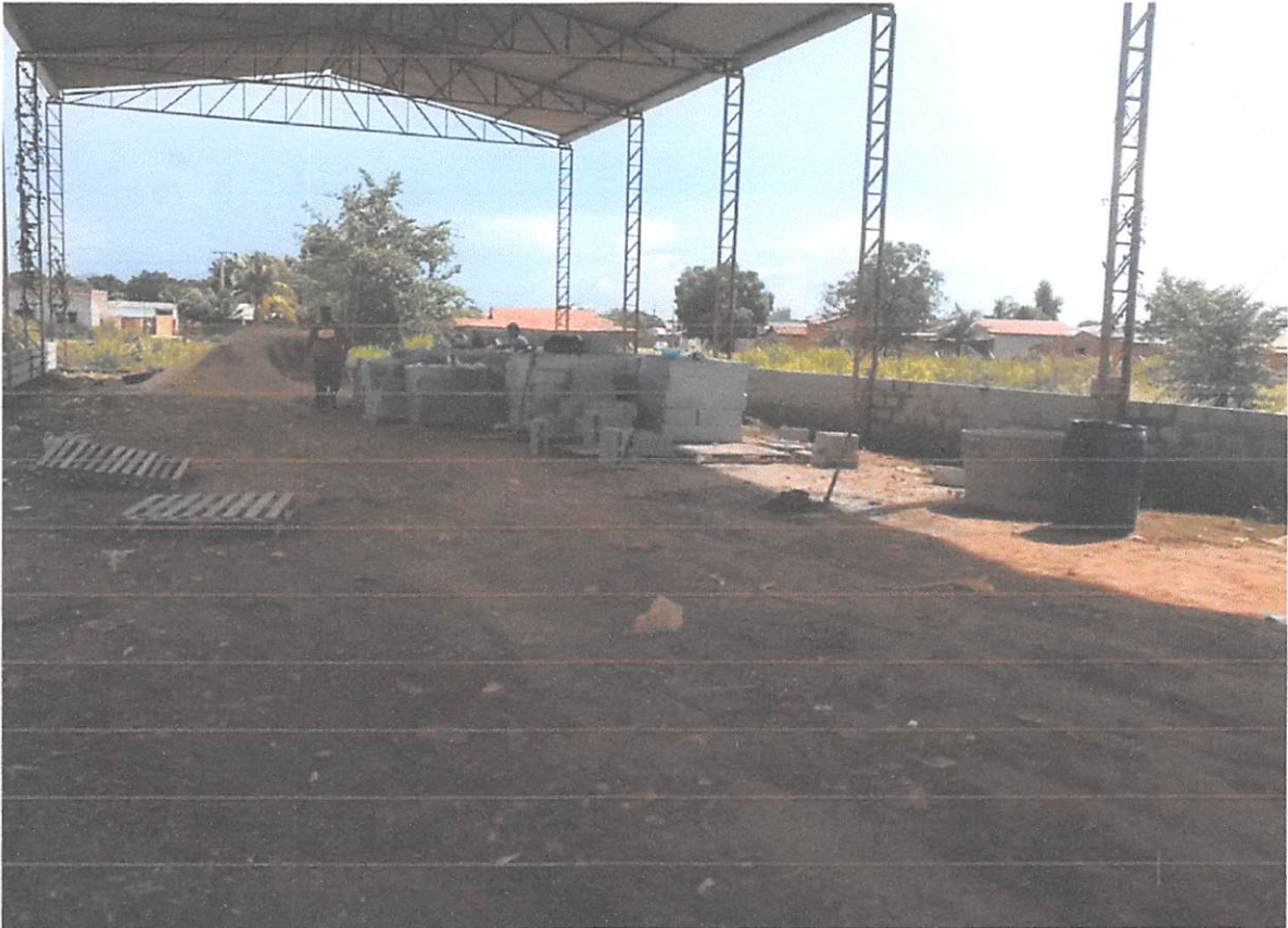
FOTO 01: Pilares de estrutura metálica existente:
