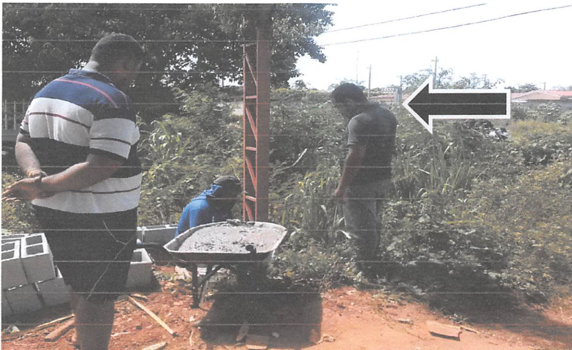
FOTO 05: Fechamento das paredes com bloco de concreto, sob minha orientação:
