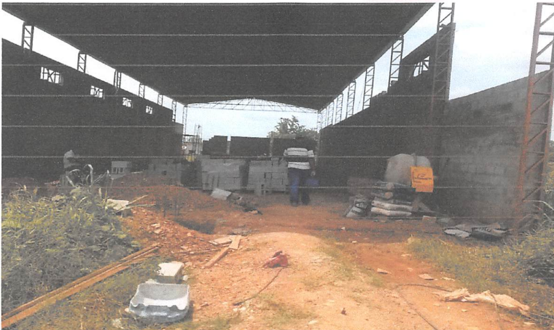
FOTO 03: Escavação de sapatas e viga baldrame:
