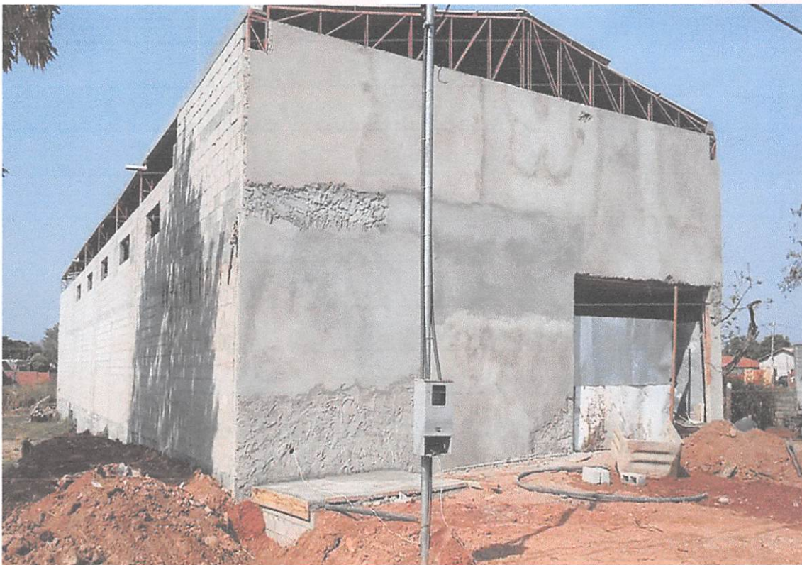
FOTO 08: Alvenaria de bloco estrutural com canaletas, vigas aéreas, com lajes na parte frontal da igreja:
