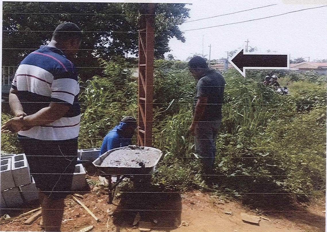
FOTO 05: Fechamento das paredes com bloco de concreto, sob minha orientação.
