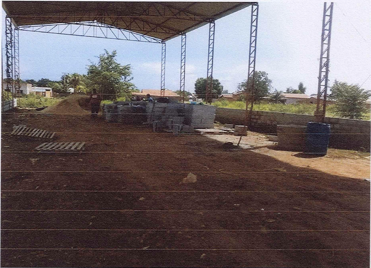
FOTO 01: Pilares de estrutura metálica existente:
