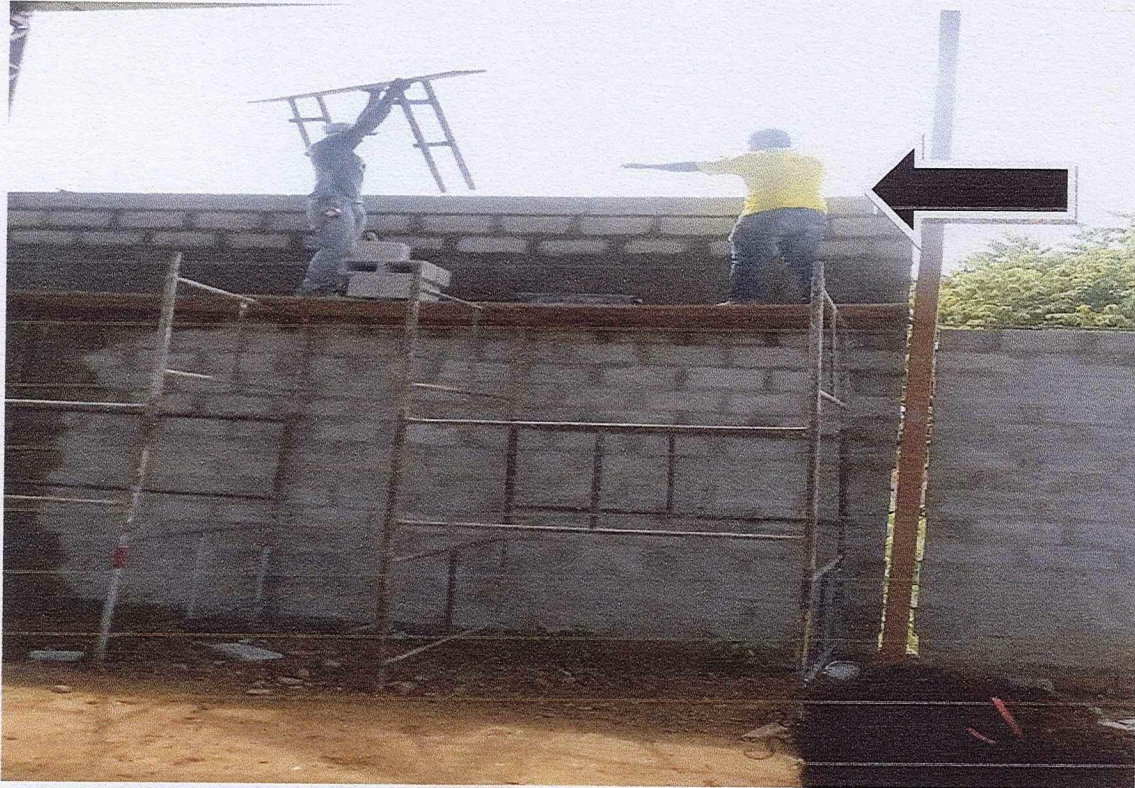
FOTO 06: Fechamento das paredes com bloco com fixação dos requadros das janelas, sob minha orientação.
