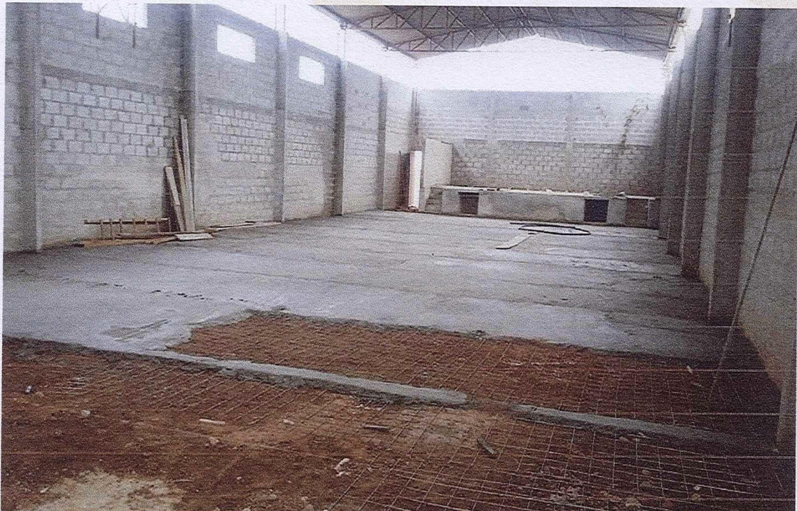
FOTO 07: Paredes com blocos de concretos, canaletas e piso com malha Q91
