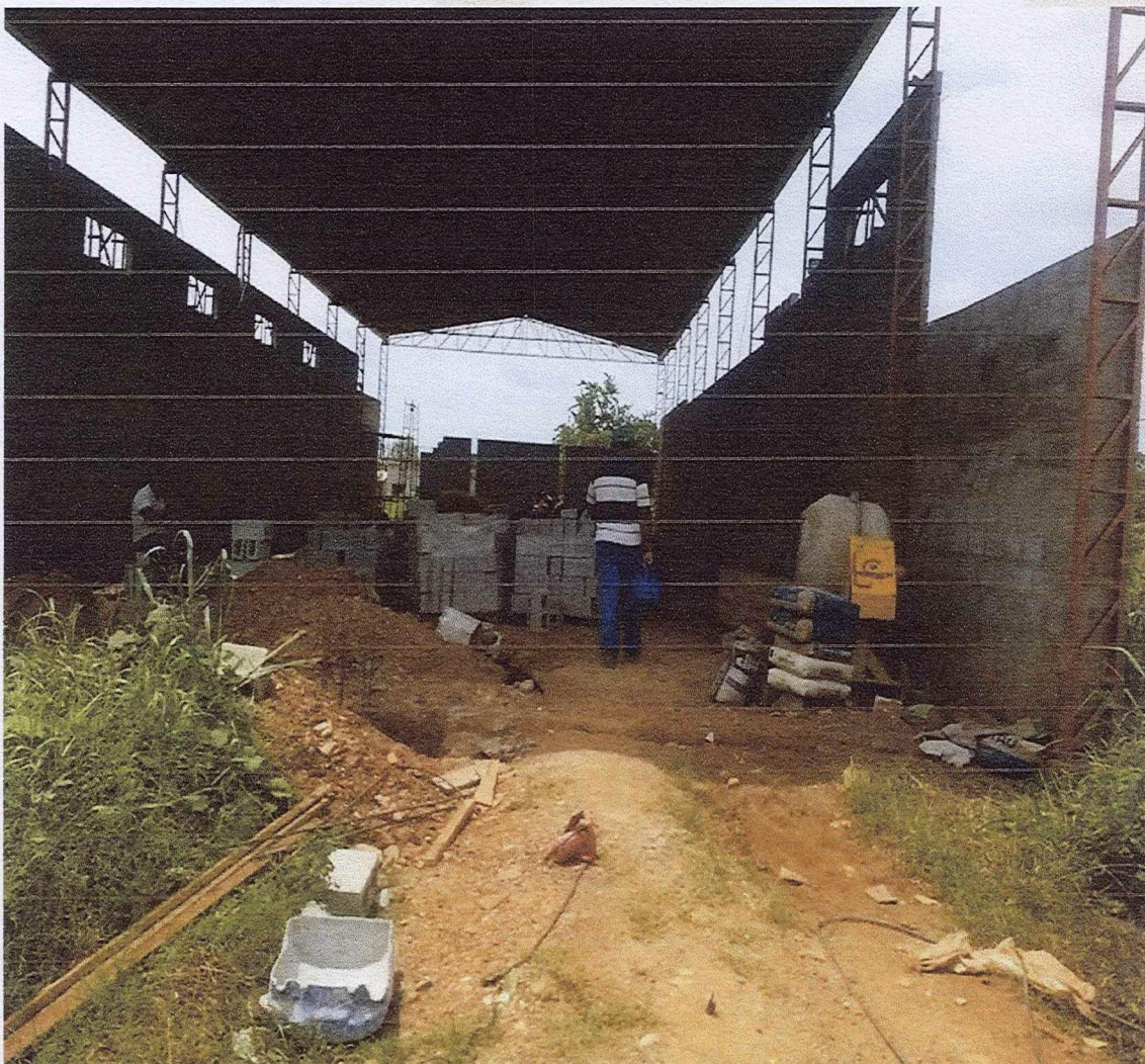
FOTO 03: Escavação de sapatas e viga baldrame.
