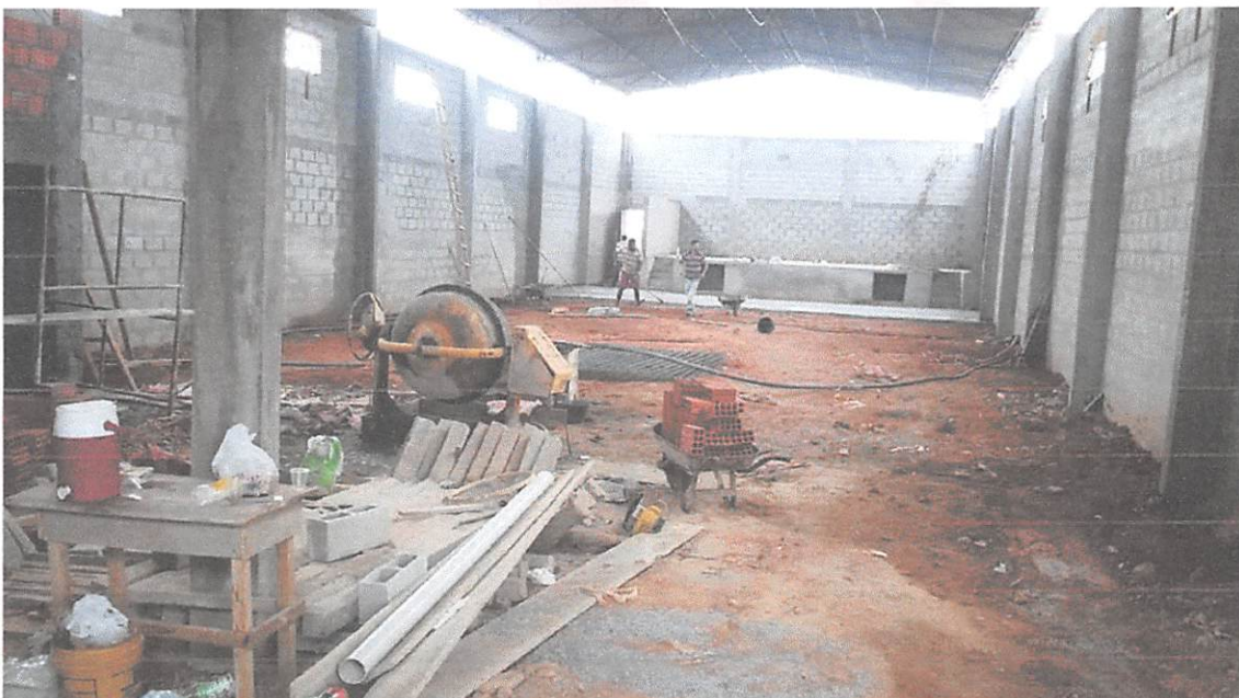
FOTO 02: Os mesmos pilares de estrutura metálica agora com reforço, com vigas aéreas em blocos de canaletas, com aço CA 50, concretados sob a minha responsabilidade:
